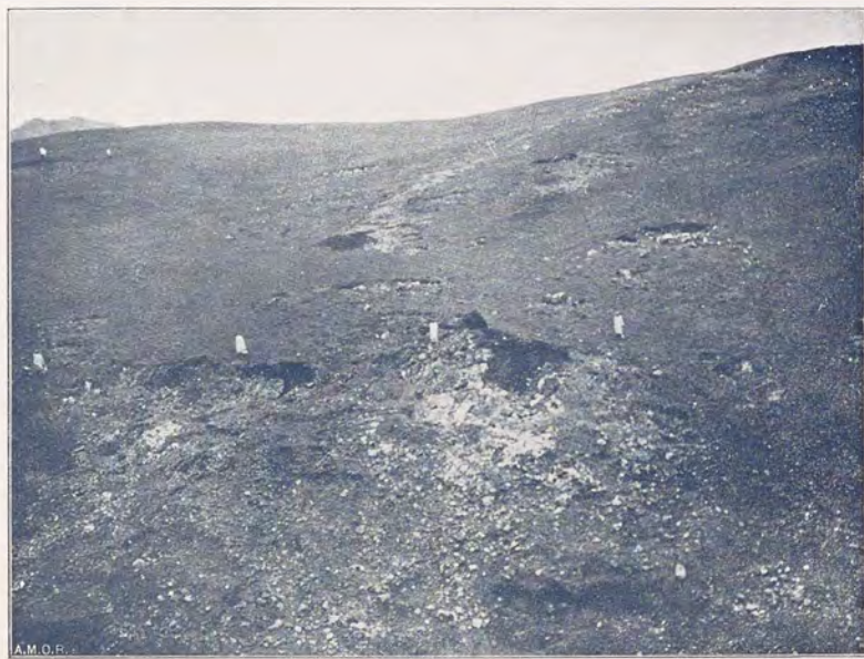
Phot. n° 16. — Vue de l'attaque du filon n° 11. Les hommes visibles sur la photographie jalonnent les affleurements.
